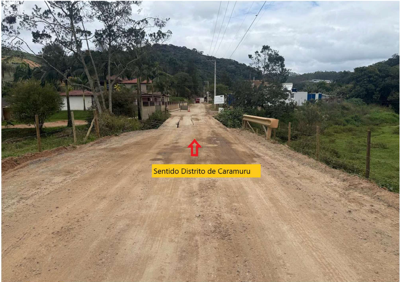
Foto 02 – Vista superior da Ponte – Ponte Distrito Caramuru – Caminho do Campo – Entr. ES-264 - Santa Maria de Jetibá/ES.
