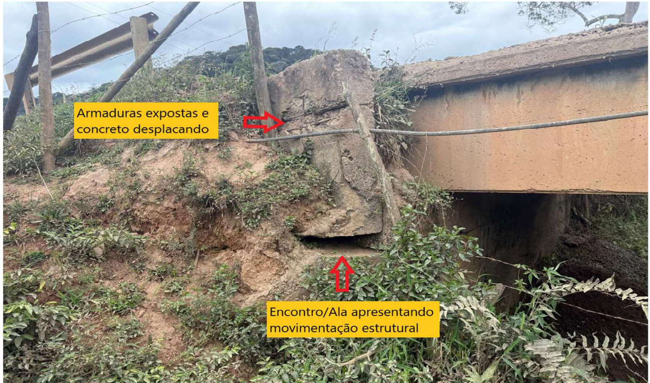
Foto 06 – Vista Mesoestrutura da Ponte – Apresentando trincas graves, armaduras expostas e oxidadas além de concreto deteriorado e deslocando.
