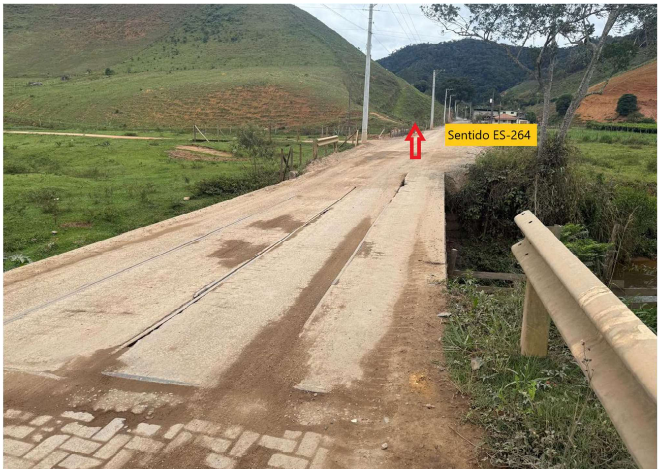
Foto 01 – Vista superior da Ponte – Ponte Distrito Caramuru – Caminho do Campo – Entr. ES-264 - Santa Maria de Jetibá/ES.
