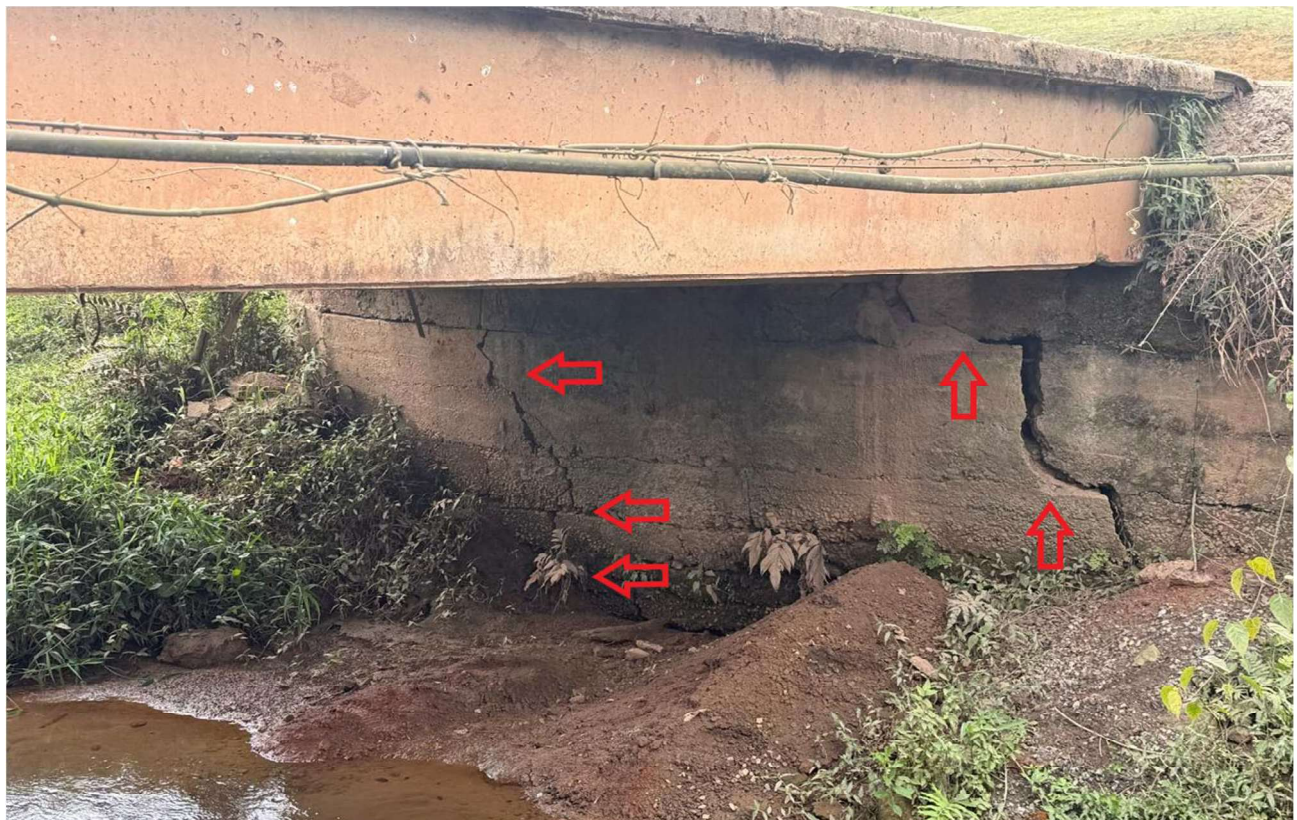
Foto 06 – Vista Mesoestrutura da Ponte – Apresentando trincas graves, armaduras expostas e oxidadas além de concreto deteriorado e deslocando.
