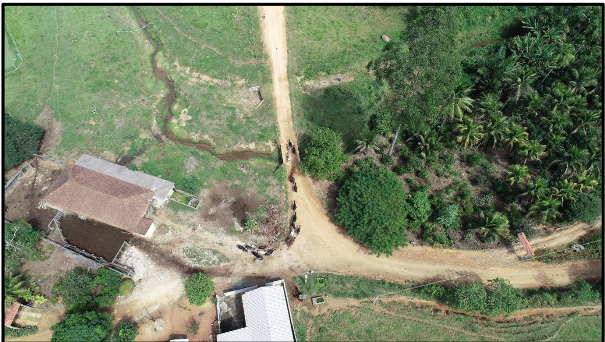
Situação do curso hídrico (CH3) Córrego da Gruta ao atravessar a estrada a ser pavimentada.
