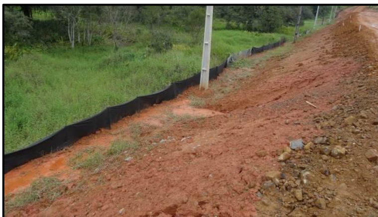
Esquema construtivo e imagem ilustrativa de uma barreira de siltagem instalada.
