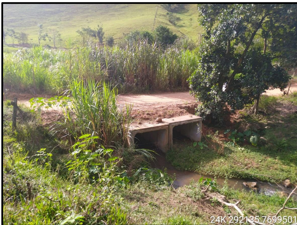
Situação do curso hídrico (CH5) Córrego Concórdia ao atravessar a estrada a ser pavimentada.
