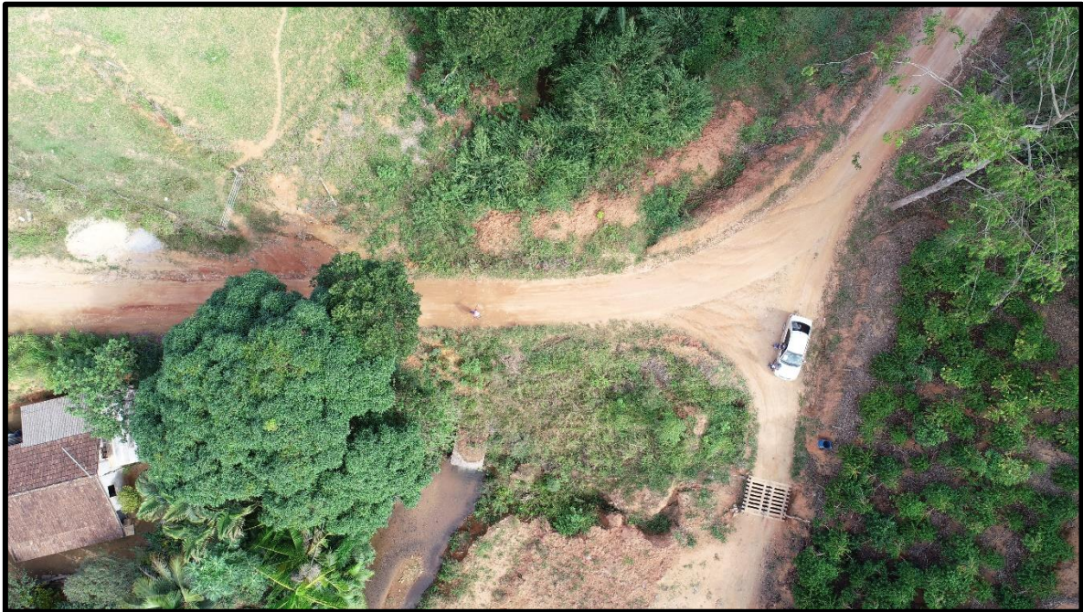
Situação do curso hídrico (CH4) Córrego Belém ao atravessar a estrada atualmente não pavimentada.
