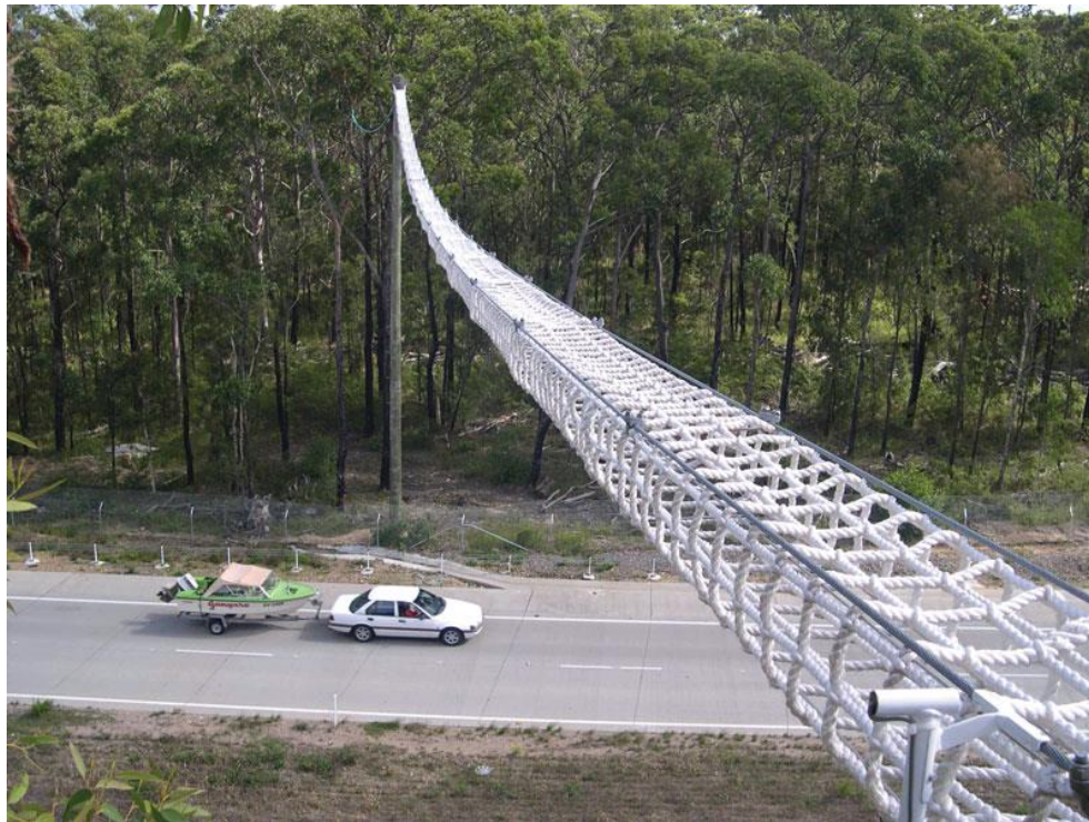
Exemplo de ponto aéreo para travessia de fauna.
