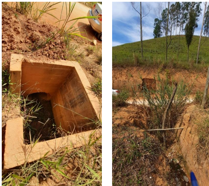
Caixa e local da Ala Est. 114+12,000.
