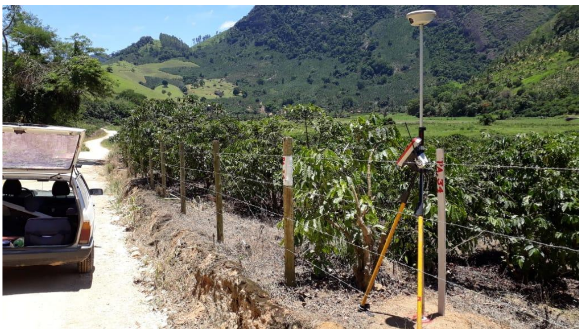
Foto: Rastreamento da poligonal de apoio.
