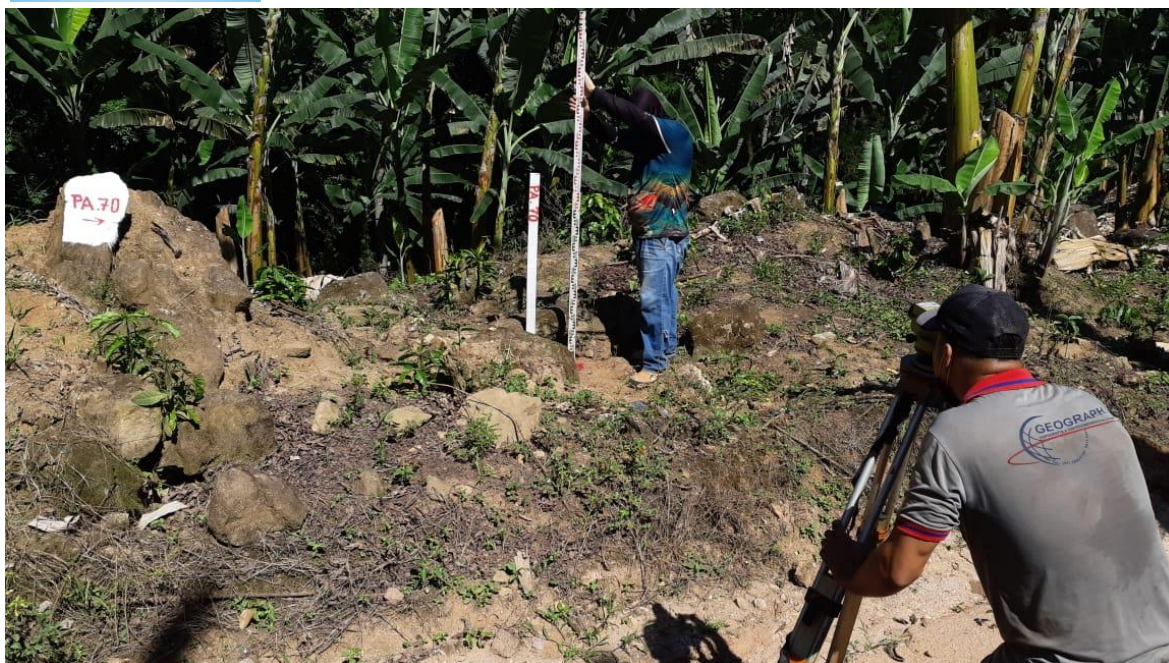
Foto: Nivelamento Geométrico.
