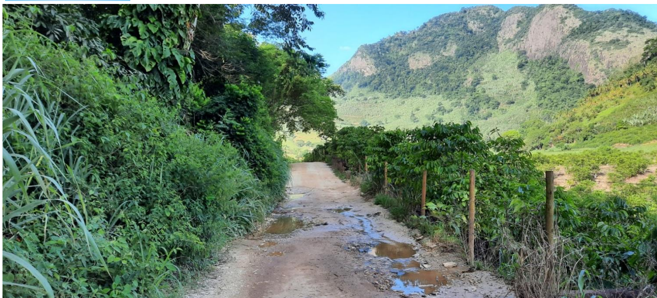
Trecho com necessidade de alargamento - Est. 210+0,00.
