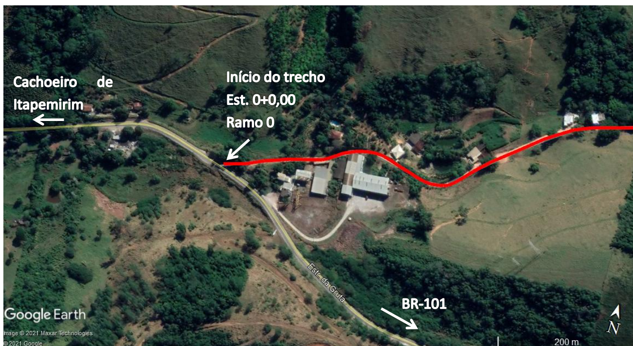
Início do Trecho – Est. 0+0,000.
