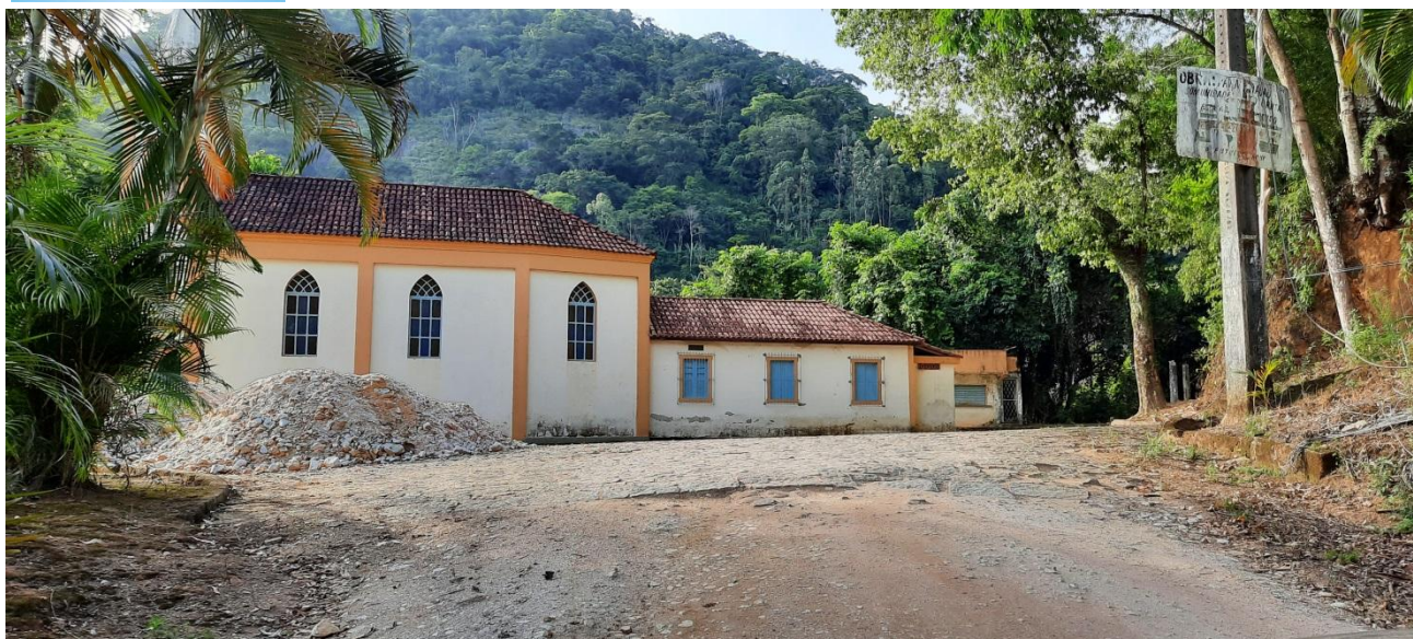
Fim do trecho Ramo 0 – Igreja Santa Isabel. Est. 360+0,000.
