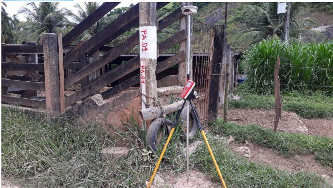
Foto: Rastreamento da poligonal de apoio.
