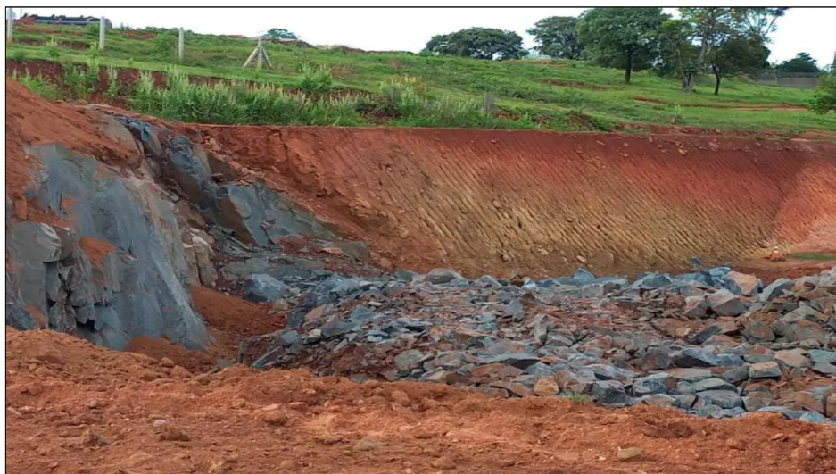
Figura: corte em rocha com fogo controlado.
