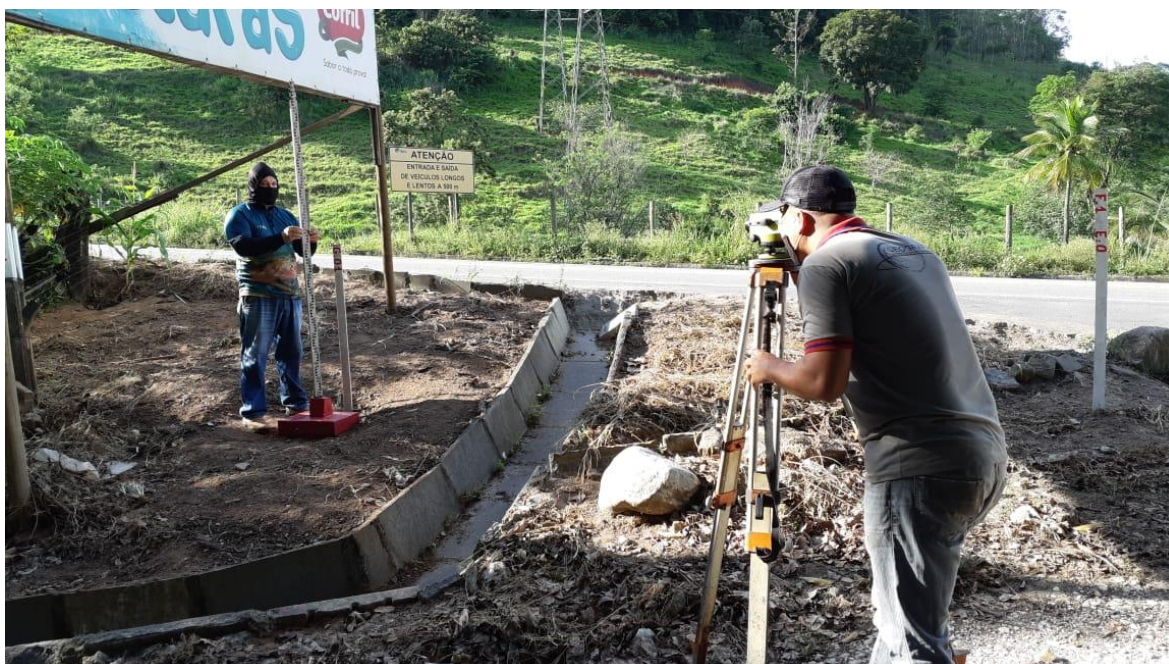
Foto: Nivelamento Geométrico.
