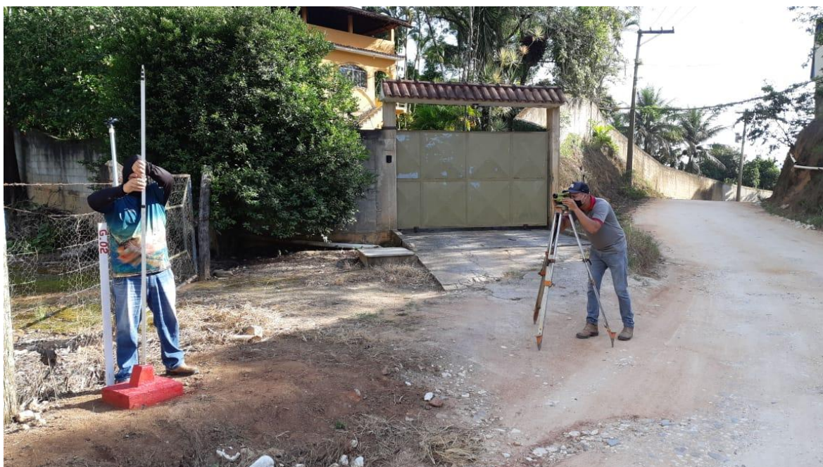
Foto: Nivelamento Geométrico.
