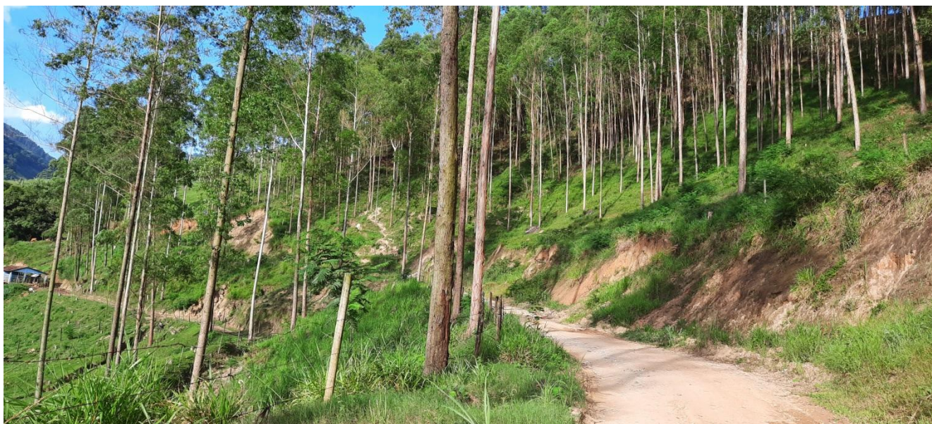
Trecho com largura adequada. Est. 290+0,000.
