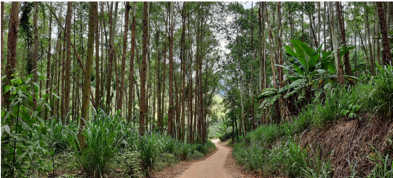
Trecho com necessidade de alargamento. Est. 230+0,000.
