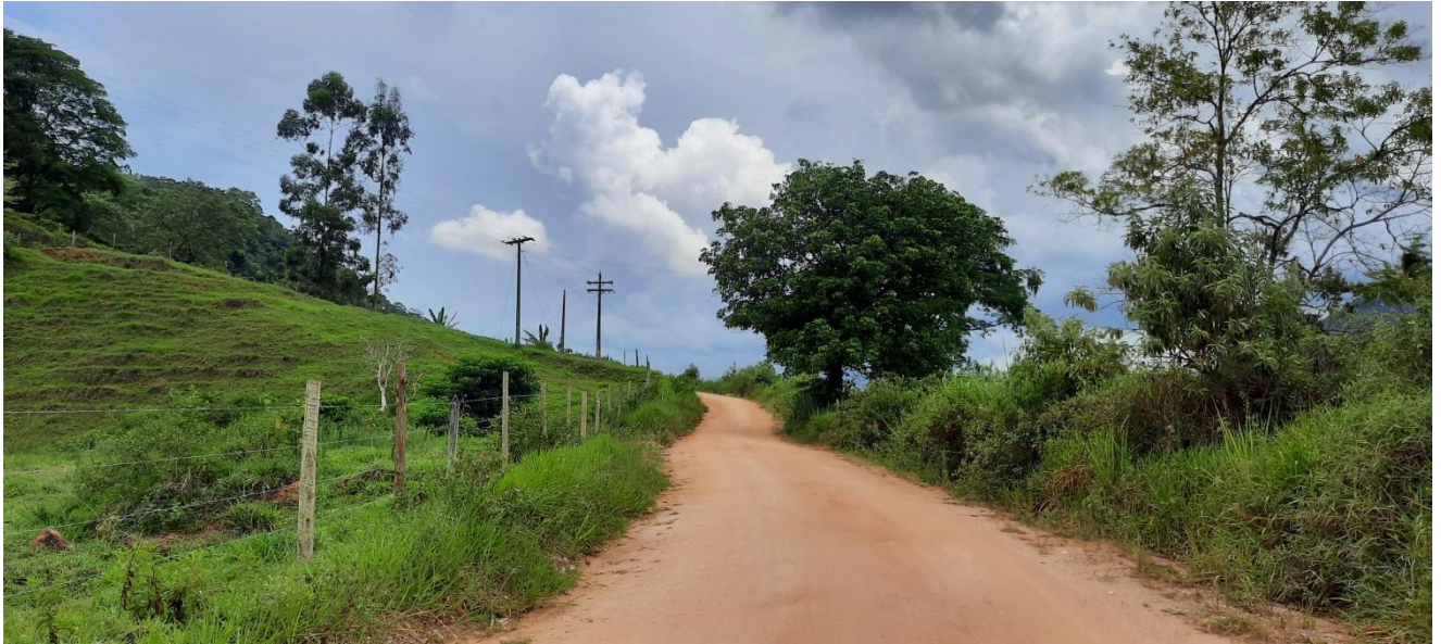
Trecho com largura adequada. Est. 140+0,000.
