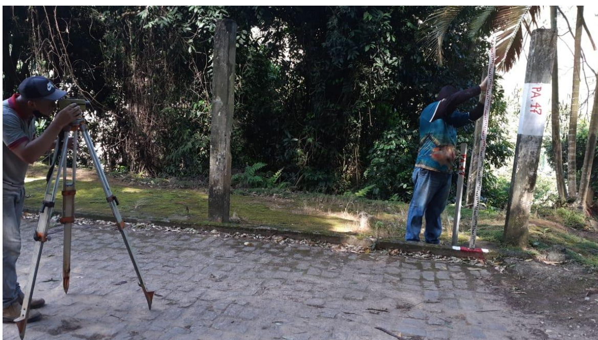
Foto: Nivelamento Geométrico.
