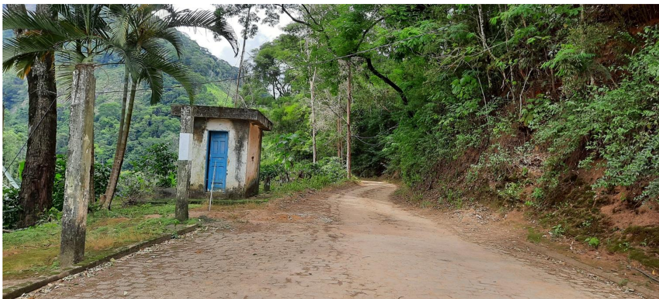
Início do trecho Ramo 100 – Final do Calçamento da Igreja Santa Isabel. Est. 100+0,000.
