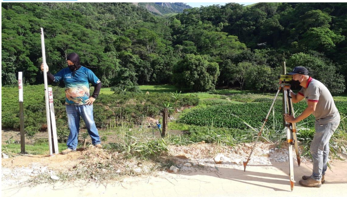
Foto: Nivelamento Geométrico.
