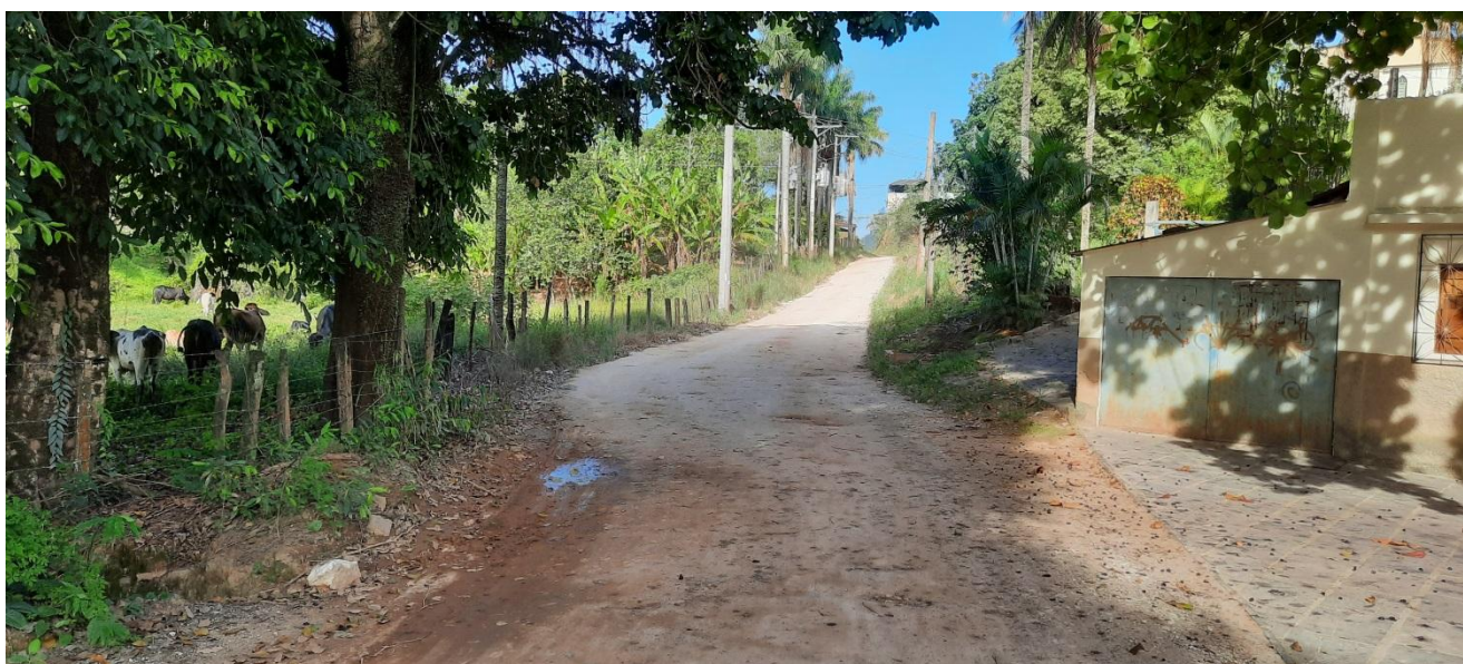
Trecho consolidado com larguras adequadas - Est.02+0,00.
