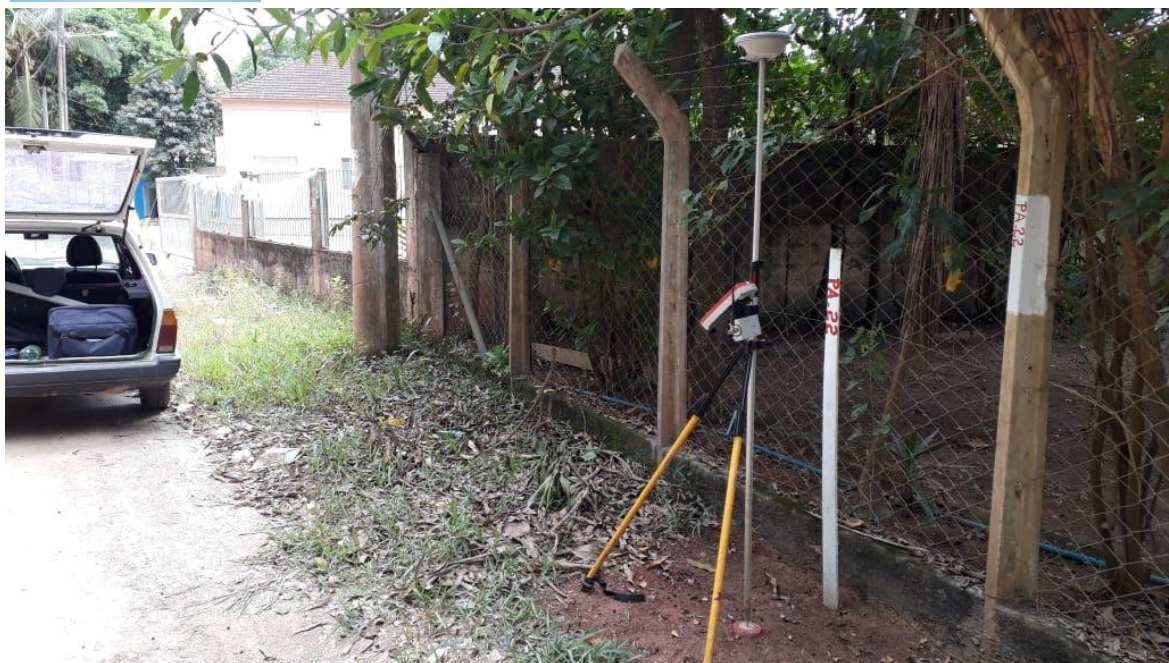
Foto: Rastreamento da poligonal de apoio.
