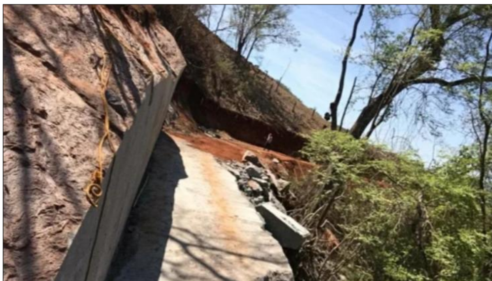
Figura: rocha cortada com fio diamantado.
