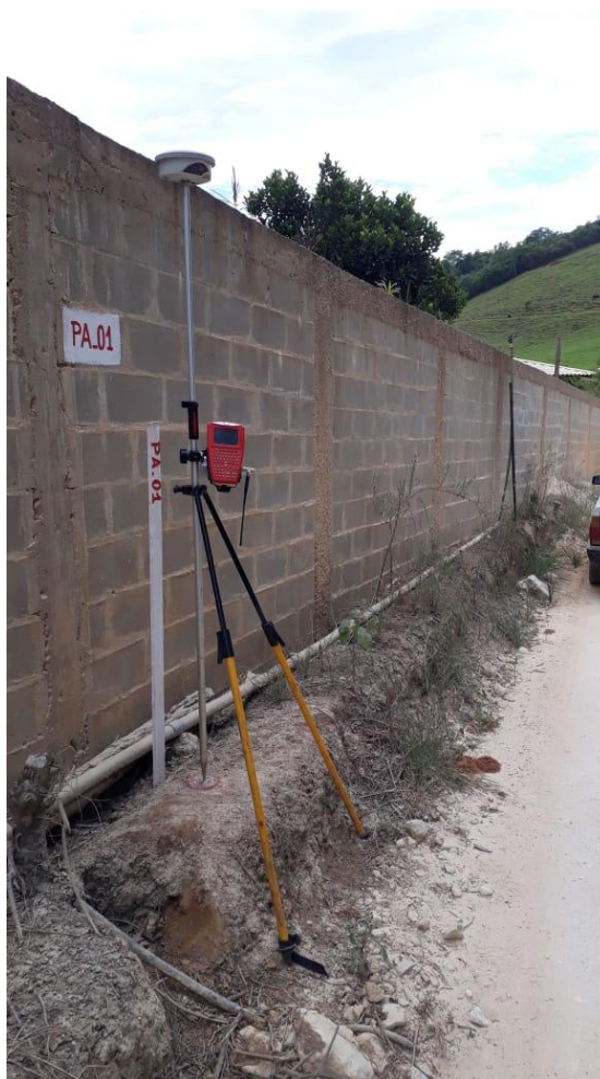
Foto: Rastreamento da poligonal de apoio.
