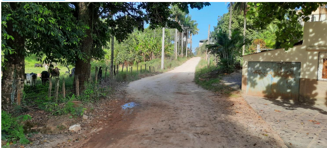
Trecho consolidado com larguras adequadas - Est.02+0,00.
