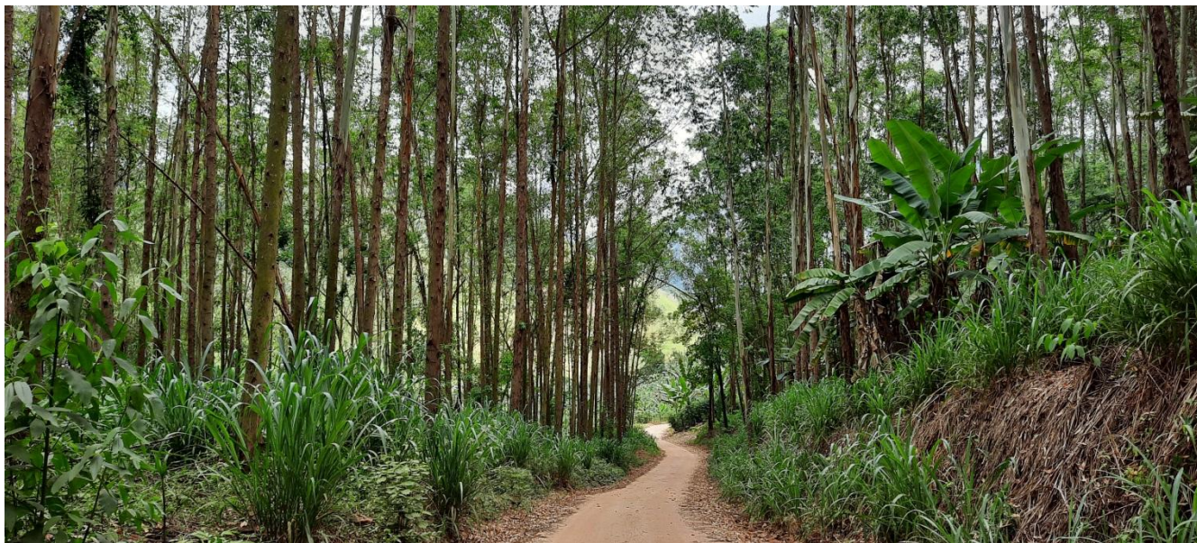
Trecho com necessidade de alargamento. Est. 230+0,000.
