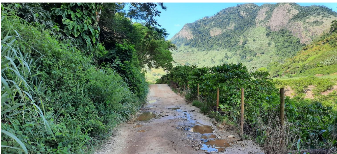
Trecho com necessidade de alargamento - Est. 210+0,00.
