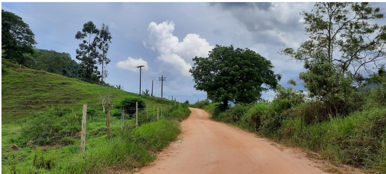
Trecho com largura adequada. Est. 140+0,000.
