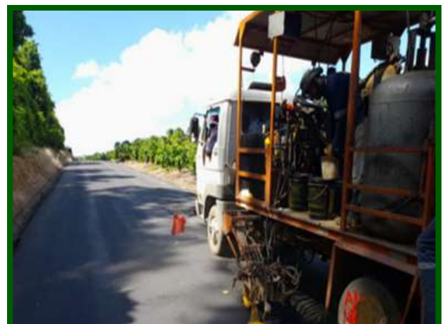
Figura 119 - Reabilitação de rodovia na localidade de Dourados - no município de Vila Valério/ES Autor: RDJ Engenharia (Contratada)
