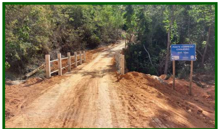
Ponte executada sobre o córrego Coqueiro - no município de Águia Branca/ES
