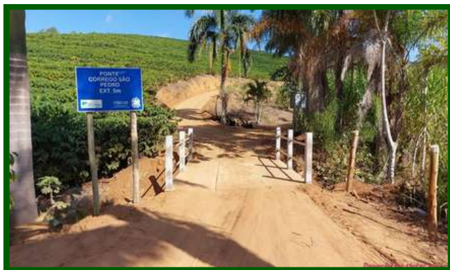
Ponte executada sobre o Córrego São Pedro - no município de Alto Rio Novo/ES
