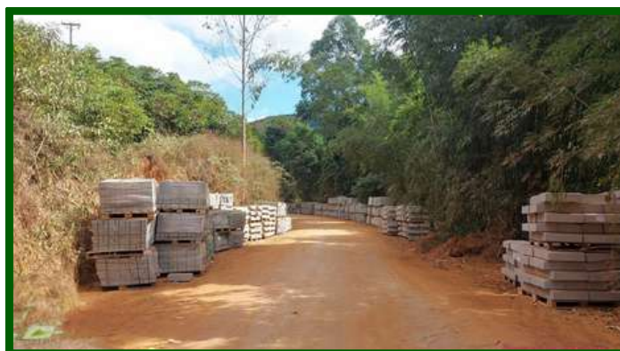
Blocos na localidade de Santa Joana, no município de Itarana/ES
