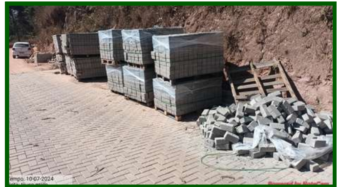
Blocos no trecho Ponto Alto – Tijuco Preto, no município de Domingos Martins/ES
