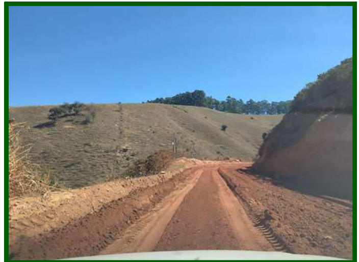
Execução da obra no trecho Sede - São Jorge (2ª ETAPA) – no município de Brejetuba/ES
