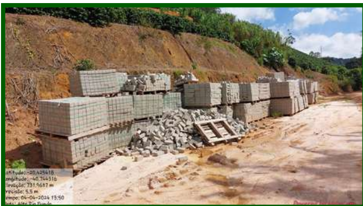
Blocos na localidade de Alto Rio Fundo, no município de Marechal Floriano/ES
