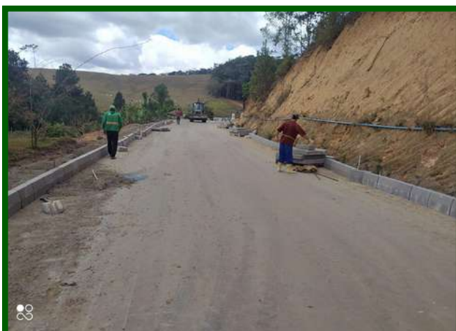
Execução da obra no trecho Rota do Carmo – no município de Domingos Martins/ES
