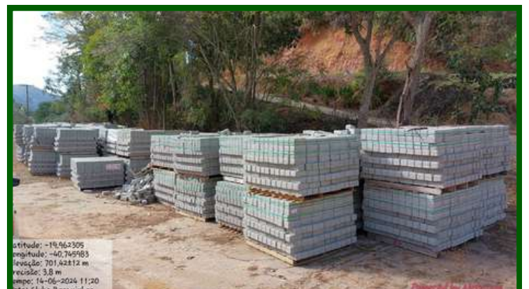
Blocos na localidade de Alto Caldeirão, no município de Santa Teresa/ES
