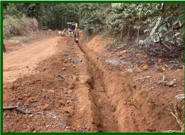
Execução da obra no trecho Sede - Parque Goiapaba-Açu- no município de Fundão/ES
