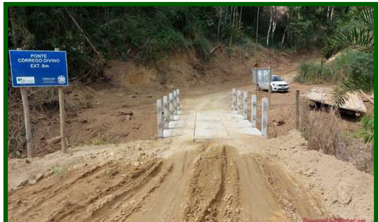
Ponte executada sobre o Córrego Divino - no município de Alto Rio Novo/ES
