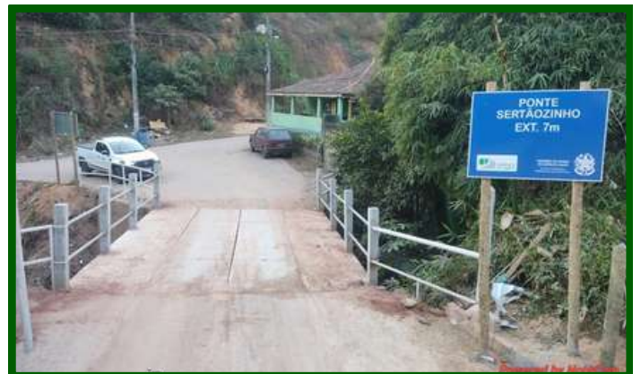
Ponte executada na localidade de Sertãozinho no município de Brejetuba/ES
