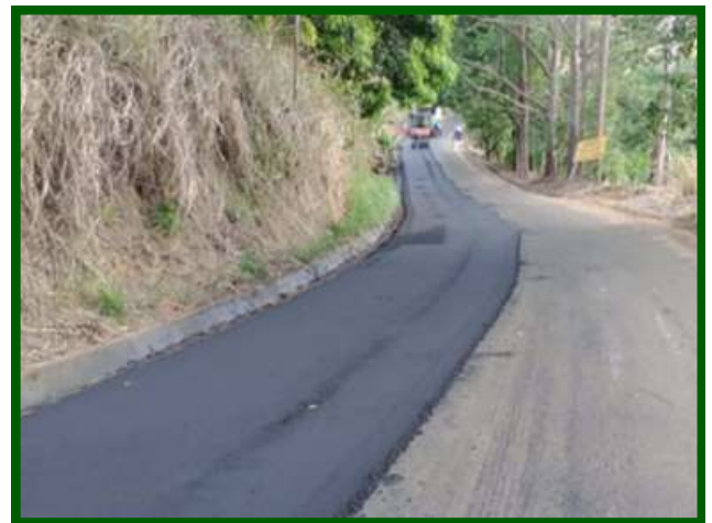
Reabilitação de rodovia na localidade de Córrego Parazinho - no município de Pancas/ES
