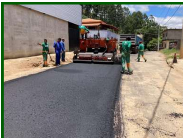
Reabilitação de rodovia na localidade de Brejaubinha – no município de Brejetuba/ES
