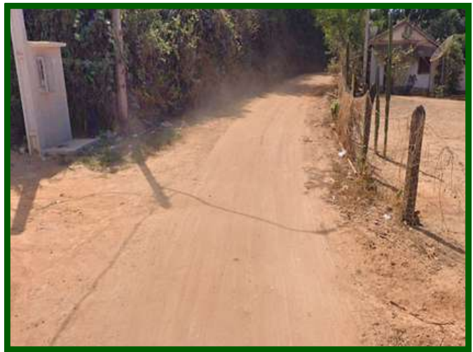
Foto: GVR - Gerência de Obras Viárias (2024)
