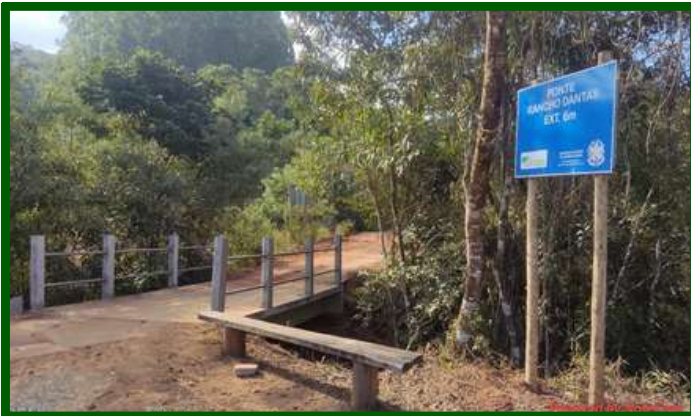
Ponte executada na localidade de Rancho Dantas – no município de Brejetuba/ES
