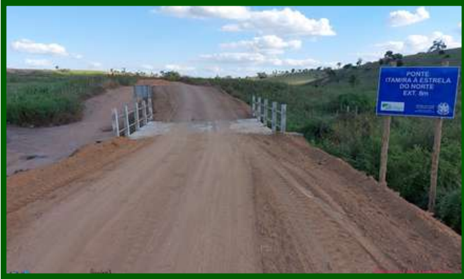
Ponte executada sobre o córrego Montanha - no município de Ponto Belo/ES
