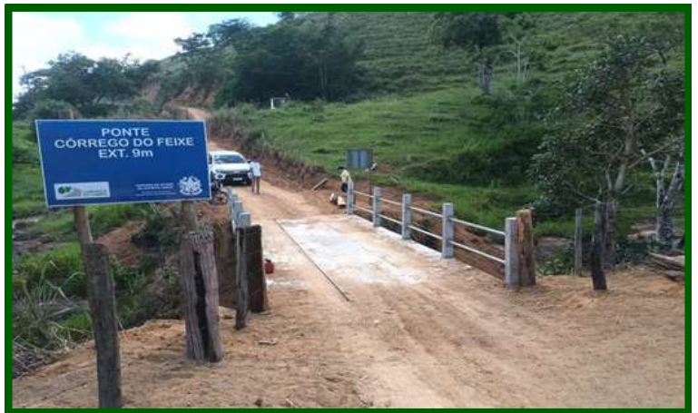
Ponte executada sobre o Córrego do Feixe - no município de Ecoporanga/ES
