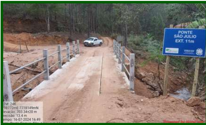
Ponte executada na localidade de São Júlio - no município de Vargem Alta/ES
