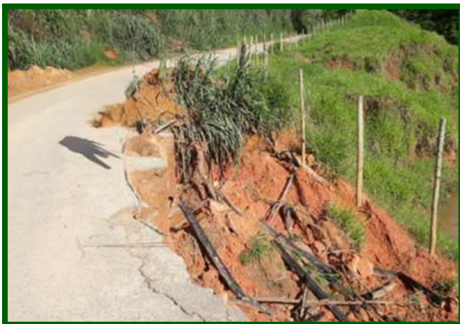
Foto: GVR - Gerência de Obras Viárias (2024)
