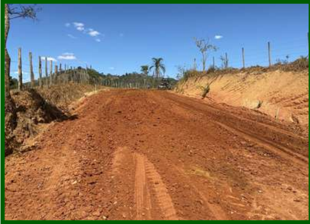
Execução da obra no trecho Gameleira - Centro de Recuperação de Dependentes Químicos - Frei Honório- no município de Nova Venécia/ES
