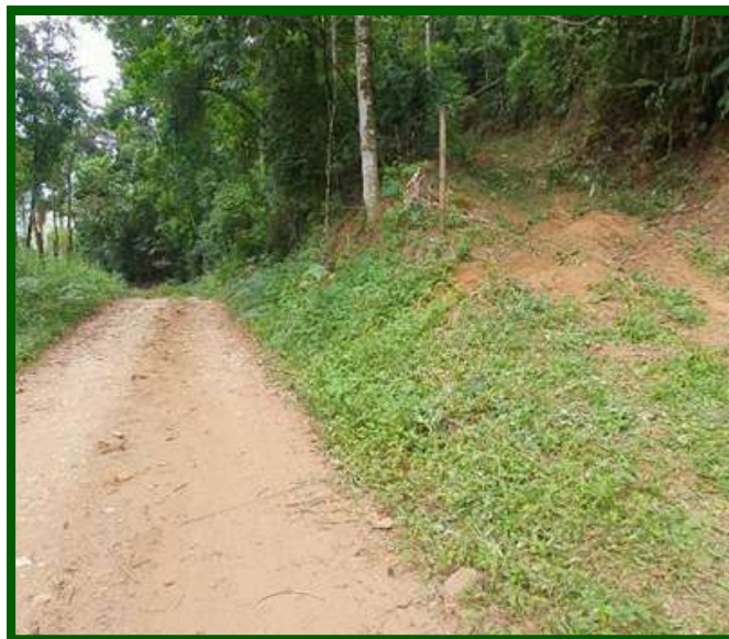
Foto: GVR – Gerência de Obras Viárias (2024)
