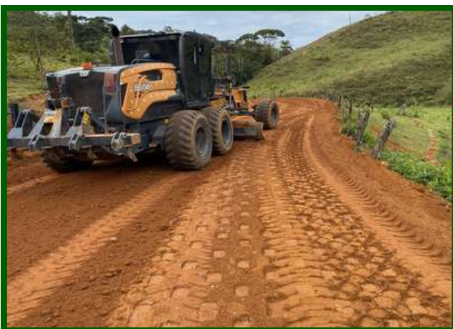
Execução da obra no trecho Formate - São Paulo de Cima- no município de Viana/ES
