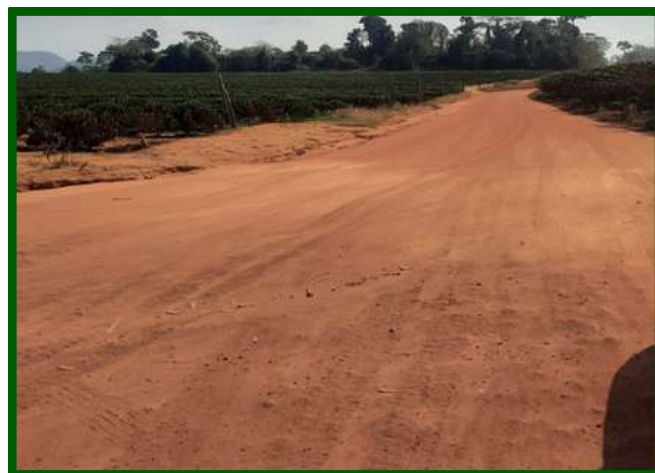
Foto: GVR – Gerência de Obras Viárias (2024)
