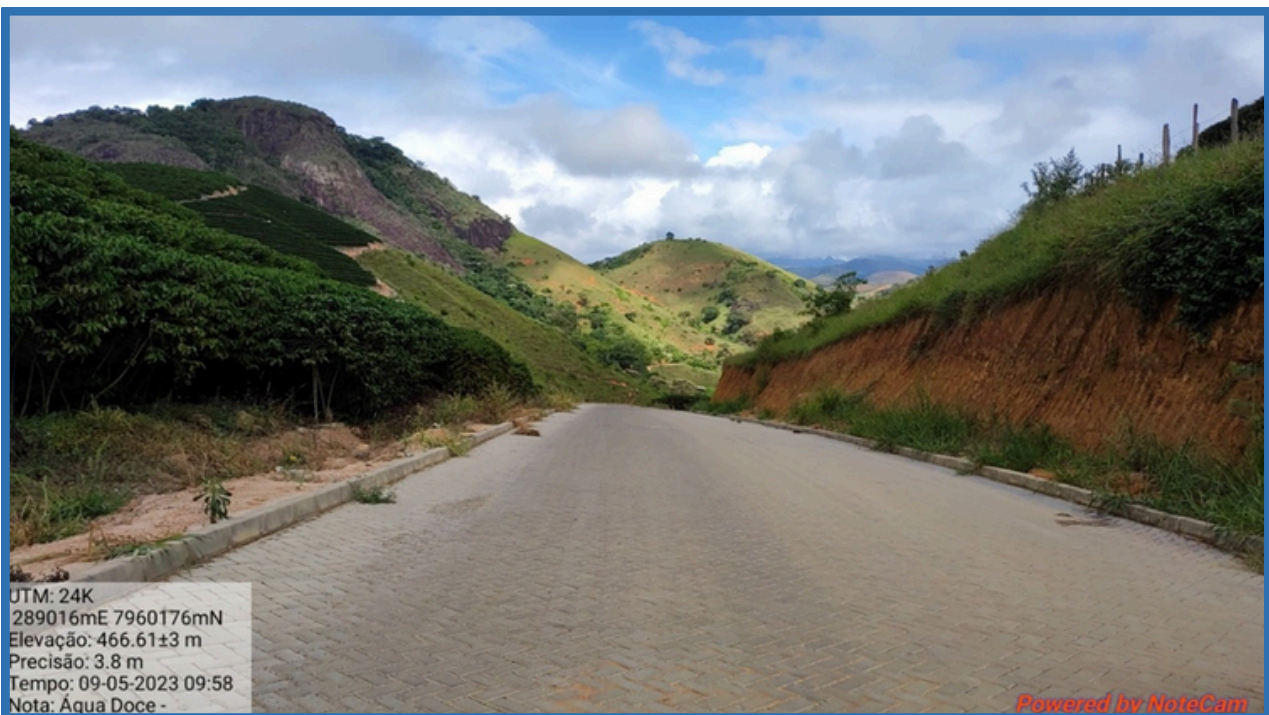
Figura 70: Calçamento Rural na localidade de Bom Destino, em Água Doce do Norte/ES. Fonte: Gerência de Obras Viárias – Subsecretaria de Infraestrutura Rural (SIR/SEAG).
