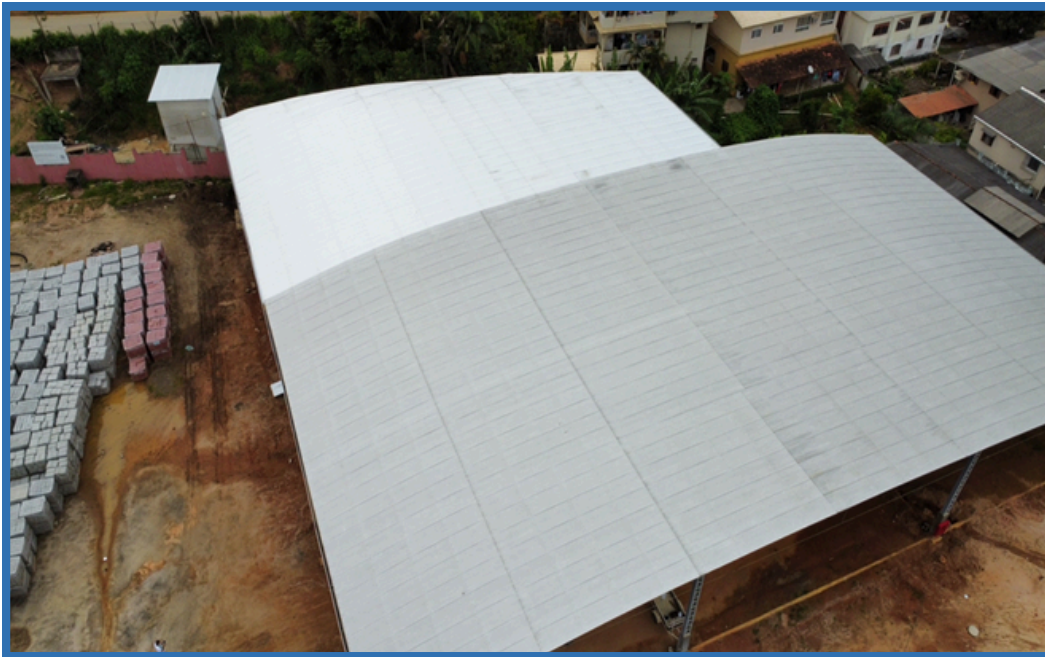
Figura 80: Obra de ampliação do Morangão em Domingos Martins/ES. Fonte: SEAG.
