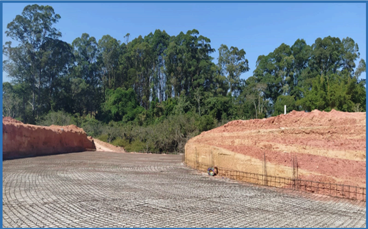
Figura 57: Construção de Barragem em Rio Quartel - Linhares/ES. Fonte: SEAG.
