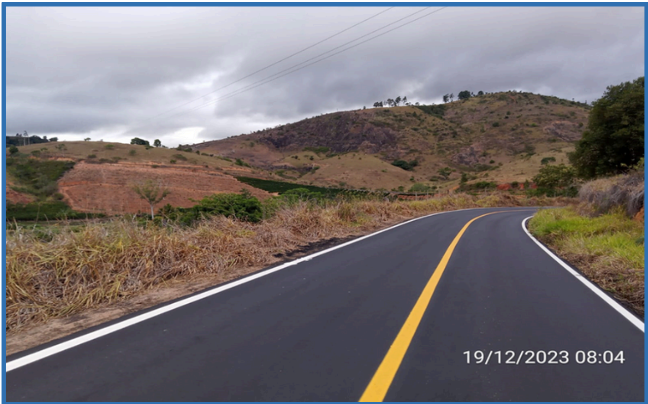
Figura 67: Recapeamento asfáltico concluído em São Domingos do Norte – Trecho que liga a localidade de Córrego Dumer à ES-137 (rodovia de acesso ao município de São Gabriel da Palha). Fonte: Gerência de Obras Viárias – Subsecretaria de Infraestrutura Rural (SIR/SEAG).
