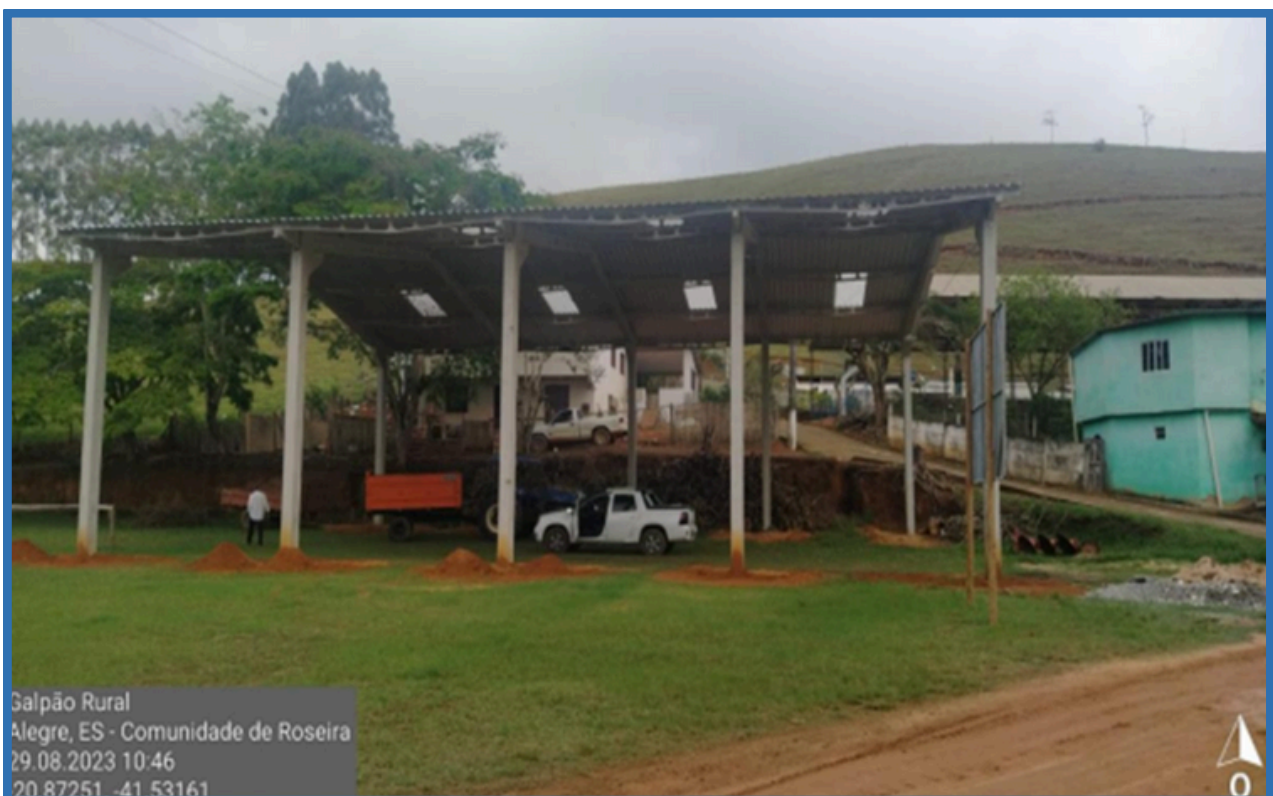
Figura 78: Galpão Rural na Comunidade de Roseira em Alegre/ES. Fonte: SEAG.
