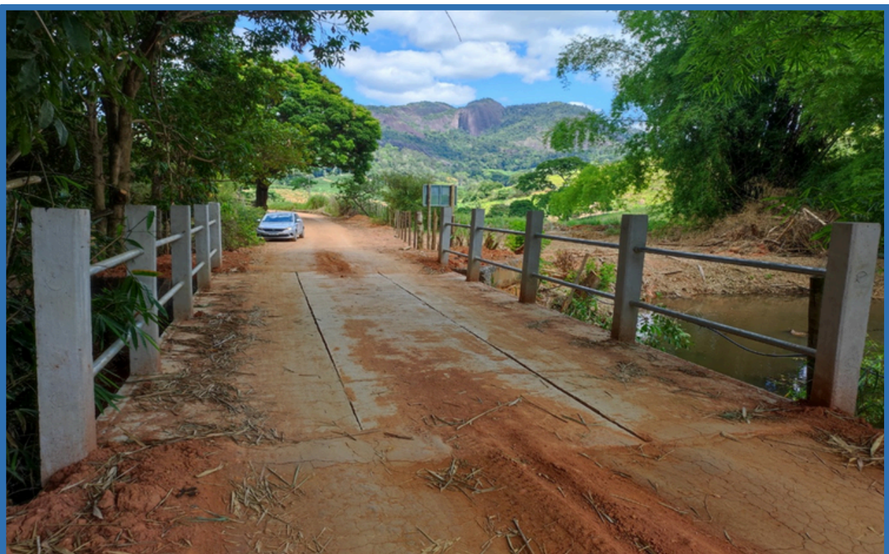
Figura 72: Ponte Rural na localidade de São Bento, em Pancas/ES. Fonte: Gerência de Obras Viárias – Subsecretaria de Infraestrutura Rural (SIR/SEAG).
