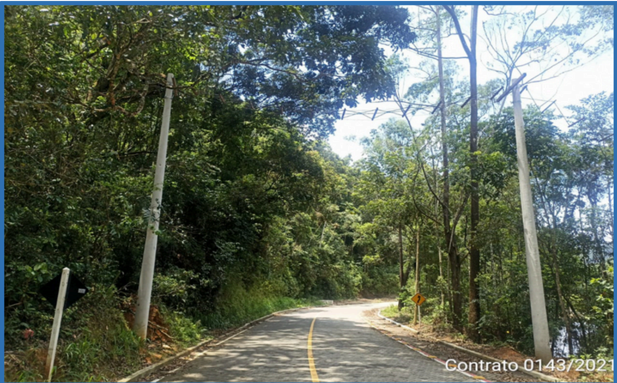
Figura 65: Obra do trecho “Matilde – Carolina” concluída, em Alfredo Chaves/ES. Fonte: Gerência de Obras Viárias – Subsecretaria de Infraestrutura Rural (SIR/SEAG).
