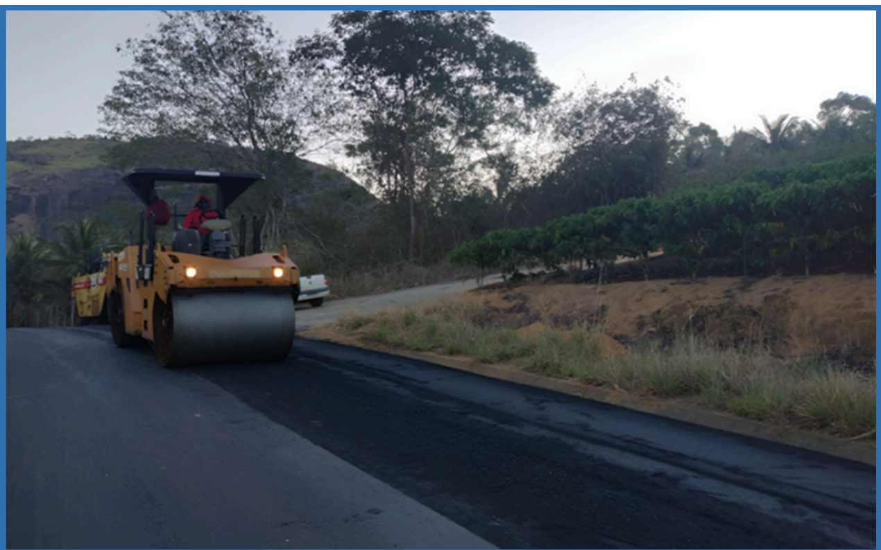
Figura 66: Recapeamento asfáltico em São Domingos do Norte – Trecho que liga a localidade de Córrego Dumer à ES-137 (rodovia de acesso ao município de São Gabriel da Palha). Fonte: Gerência de Obras Viárias – Subsecretaria de Infraestrutura Rural (SIR/SEAG).
