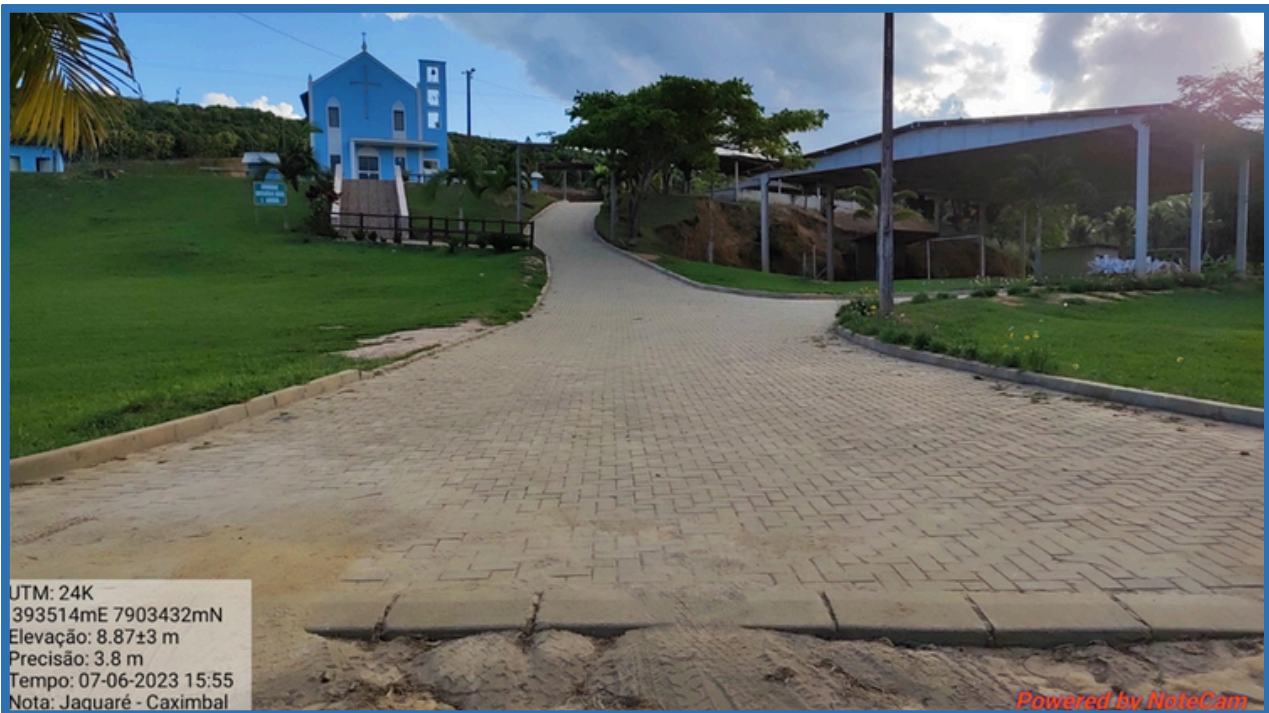
Figura 69: Calçamento Rural na localidade de Caximbal, em Jaguaré/ES. Fonte: Gerência de Obras Viárias – Subsecretaria de Infraestrutura Rural (SIR/SEAG).
